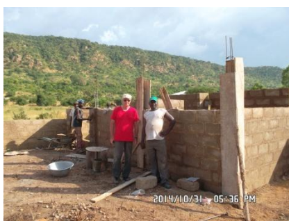
Murs de la maison du gardien
