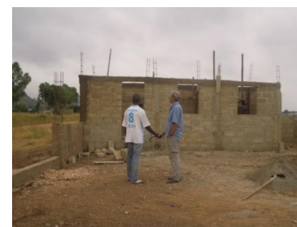
Cette fois, les murs sont montés...
