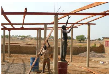
La charpente avance
