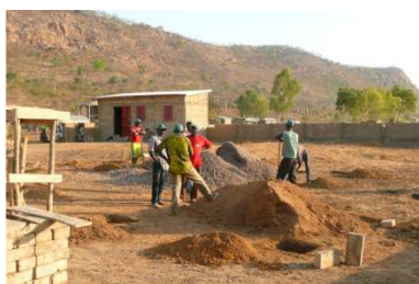
Début des travaux
