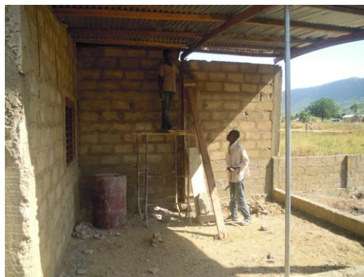
On consolide une charpente à Tanguiéta
